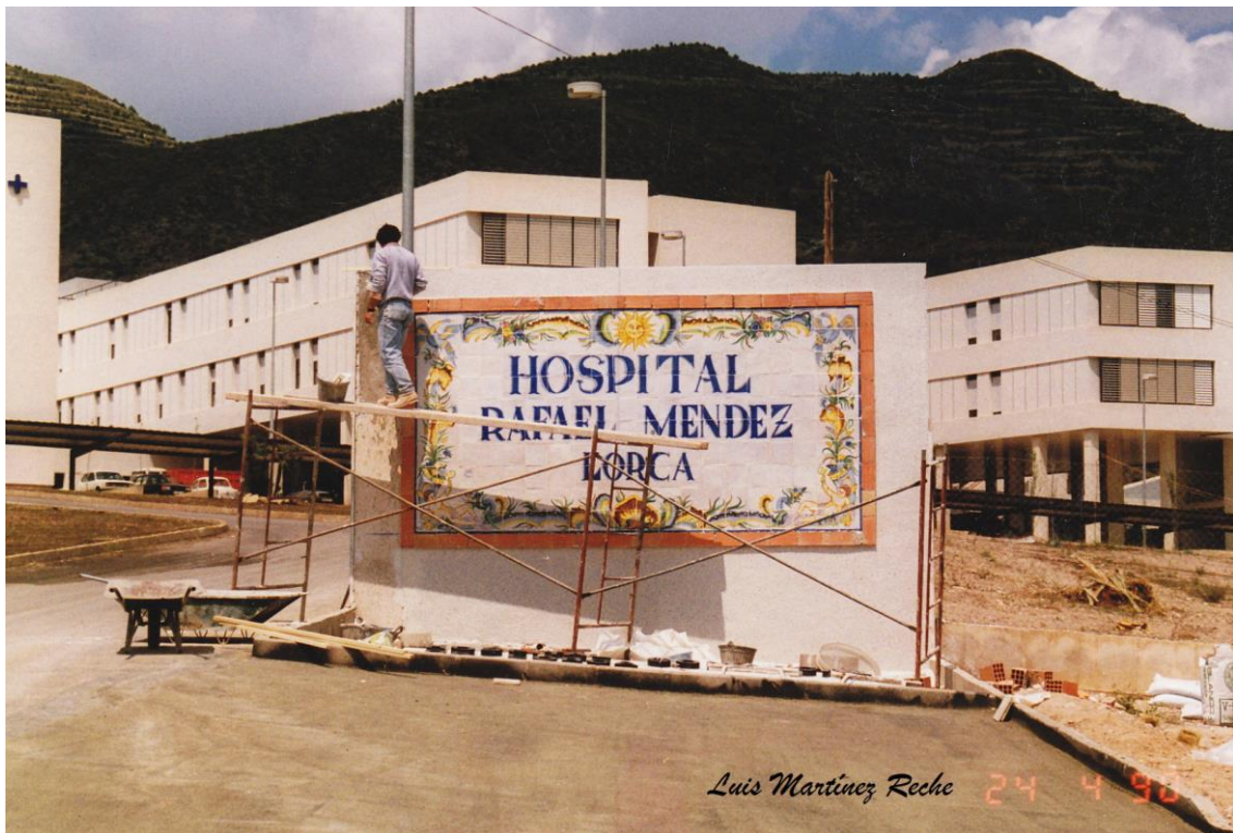
Últimos retoques a la construcción del hospital Rafael Méndez de Lorca, terminando el mural de entrada. Es el 24 de abril de 1990.
